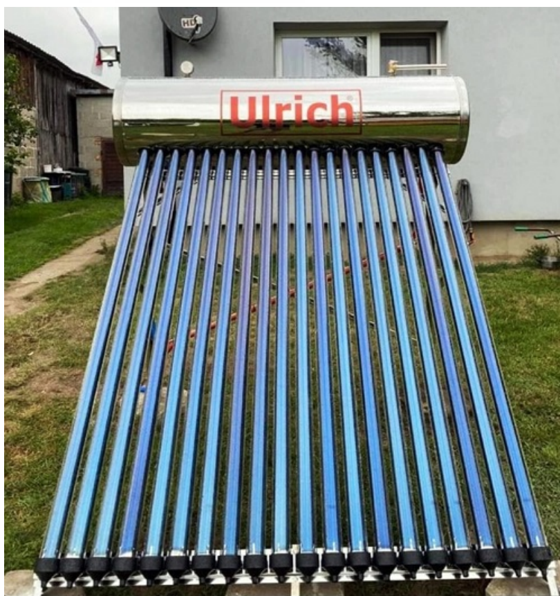
Zestaw kolektorów słonecznych do instalacji glikolowej
